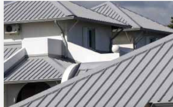
Metal Çatı ve Elemanları
